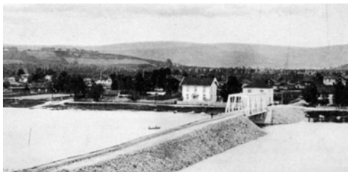
Nitelva bru ble bygget rundt 1910
