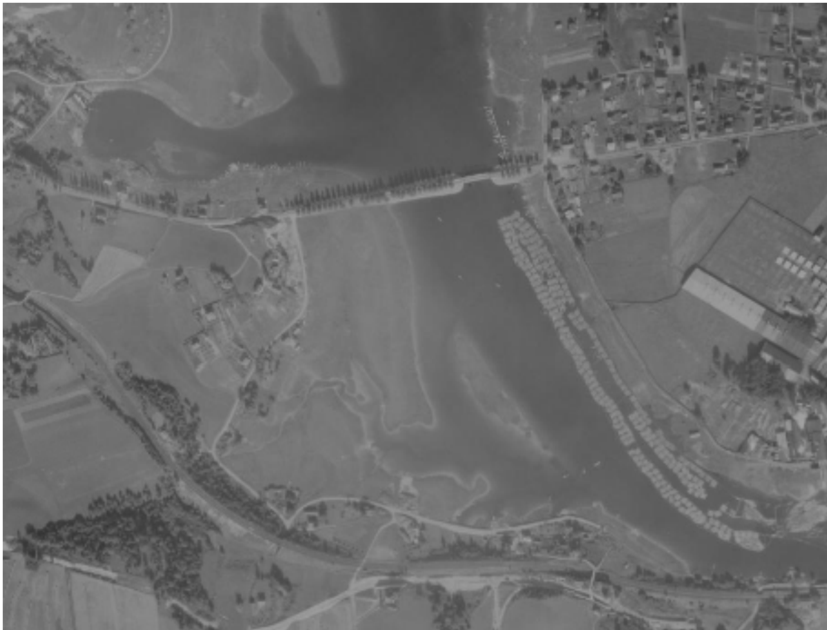
1939 Hvor Nitelva bru er bygget og avskjærer Saglevas løp
