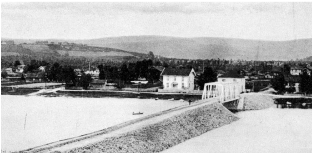
Nitelva Bru ble påbegynt i 1910 og slutført 1911.
