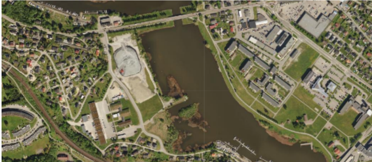
2017 Etter riving av driftsbygg, sanering av jordmasser og tilførsel av sprengsteinlager
