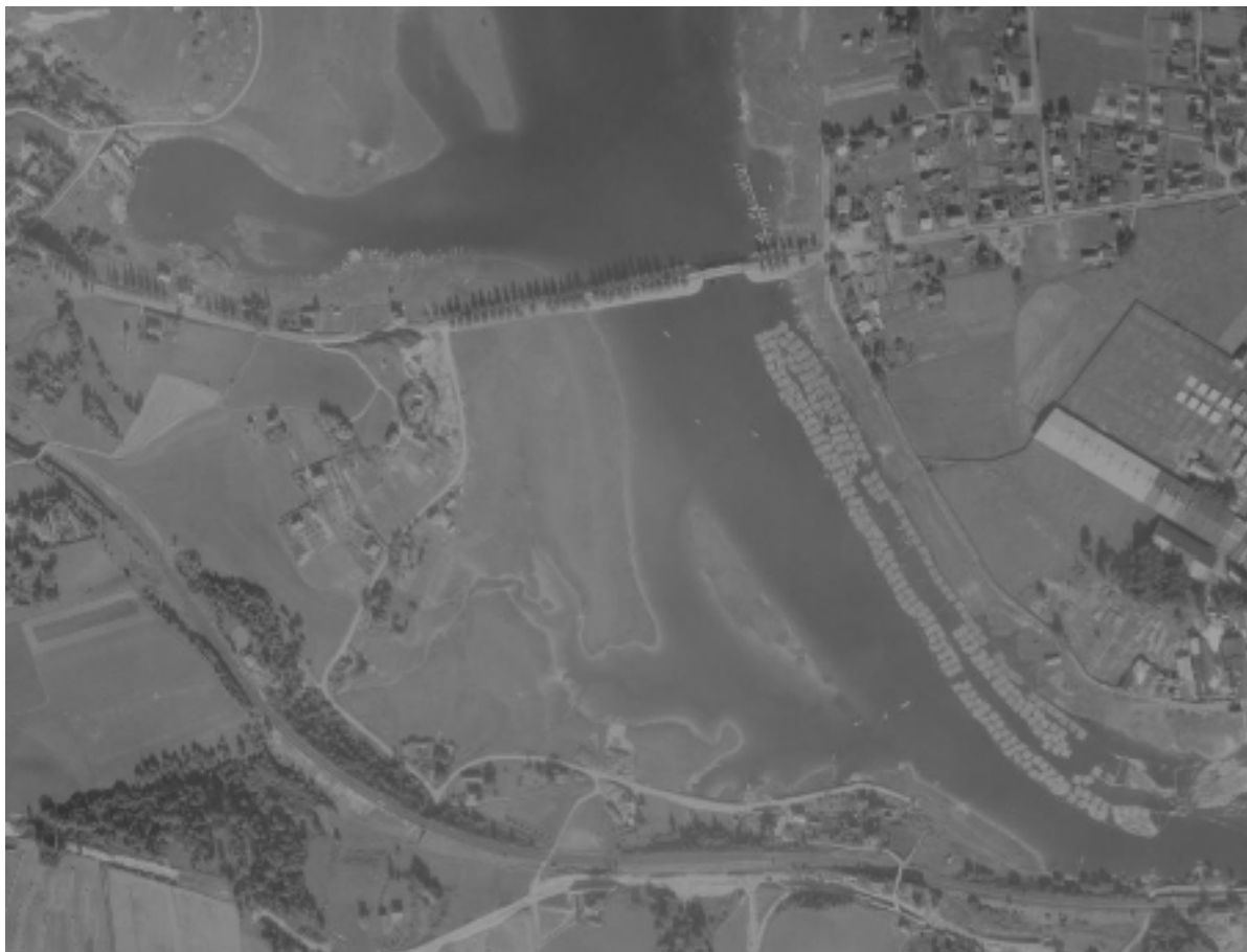
1939 Hvor Nitelva bru er bygget og avskjærer Sagelvas løp
