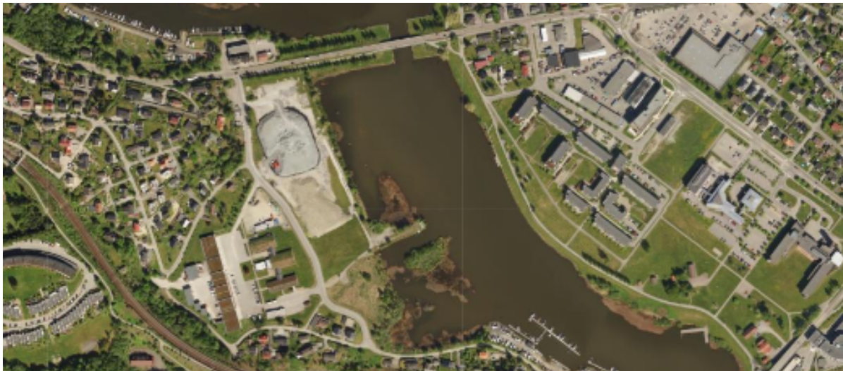
2017 Etter riving av driftsbygg, sanering av jordmasser og tilførsel av sprengsteinlager
